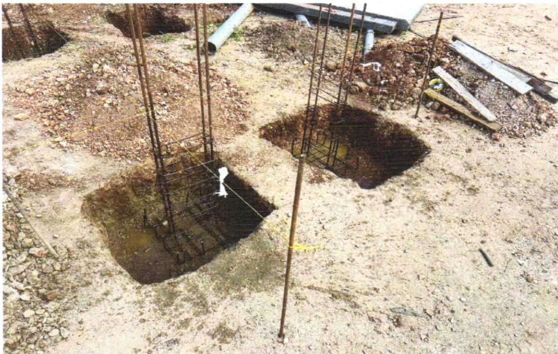
FOTO 08 – Regularização e compactação do fundo de valas
