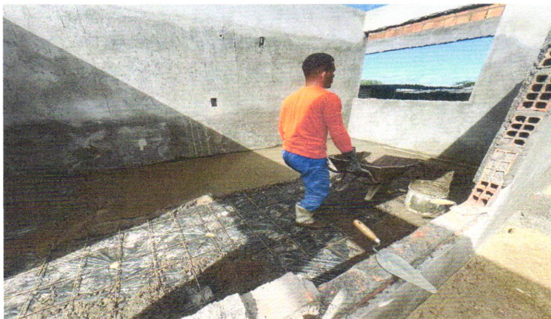
FOTO 39 – Contrapiso de concreto não-estrutural, espessura 3cm e preparo mecânico
