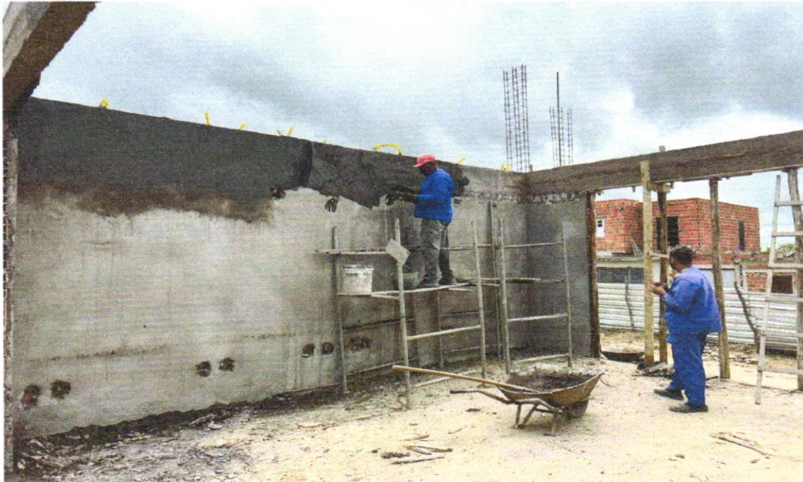
FOTO 26 – Reboco para paredes internas, externas, pórticos, vigas, traço 1:4,5 - espessura 0,5 cm
