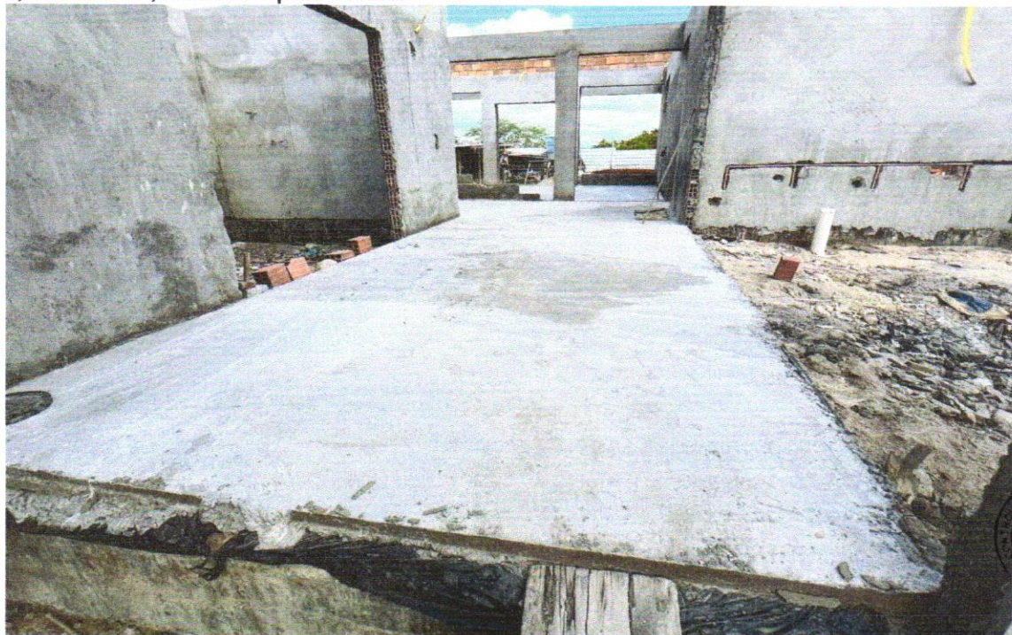
FOTO 44 – Piso cimentado desempenado com acabamento liso espessura 2,0cm com junta plastica acabada 1,2m - solários, varandas e pátio coberto
