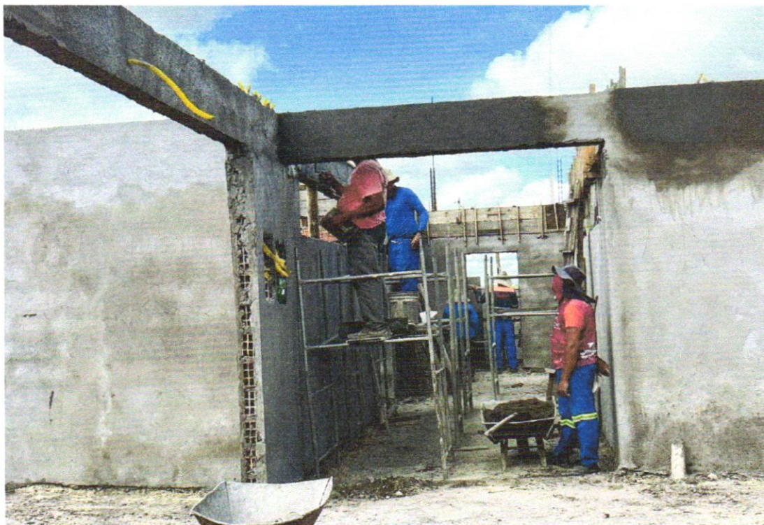
FOTO 24 – Emboço paulista para paredes externas traço 1:2:9 - preparo manual - espessura 2,5 cm
