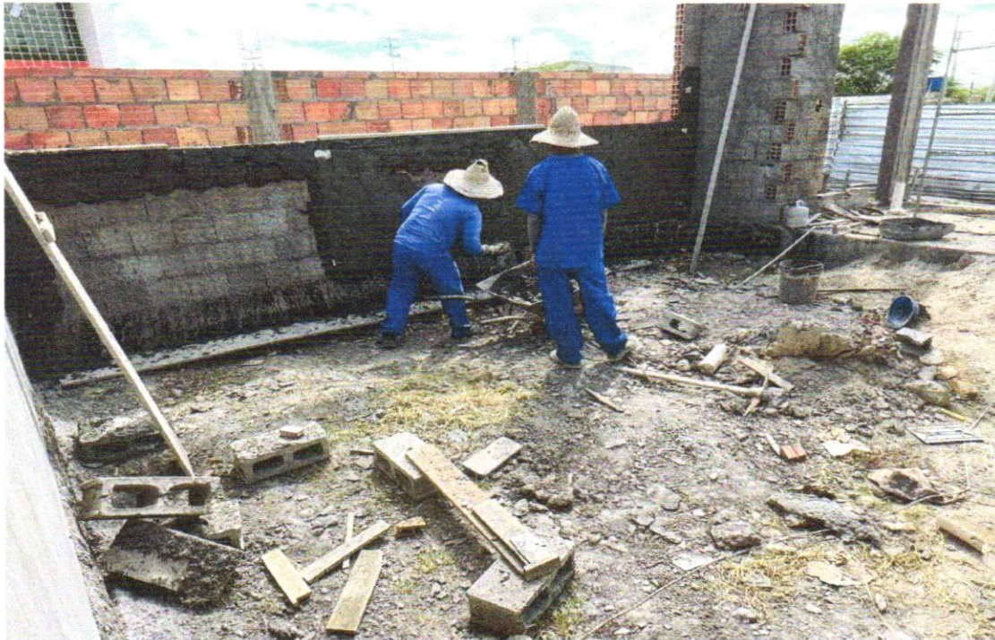
FOTO 24 – Emboço paulista para paredes externas traço 1:2:9 - preparo manual - espessura 2,5 cm
