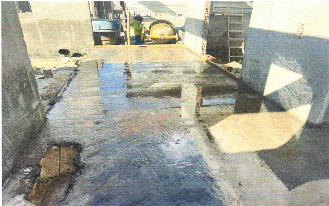
FOTO 44 – Piso cimentado desempenado com acabamento liso espessura 2,0cm com junta plastica acabada 1,2m - solários, varandas e pátio coberto
