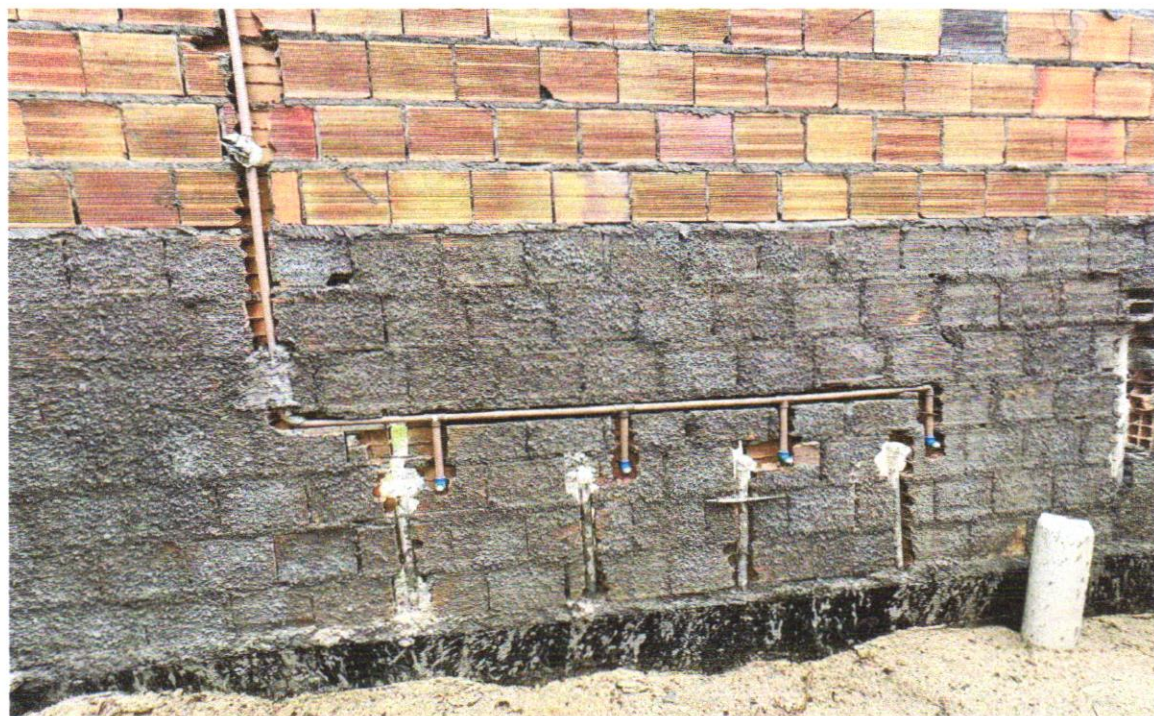
FOTO 28 – ADAPTADOR CURTO COM BOLSA E ROSCA PARA REGISTRO, PVC, SOLDÁVEL, DN 25MM X 3/4”, INSTALADO EM PRUMADA DE ÁGUA - FORNECIMENTO E INSTALAÇÃO. AF_12/2014
