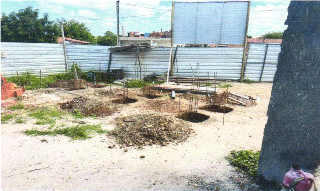
FOTO 08 – Regularização e compactação do fundo de valas
