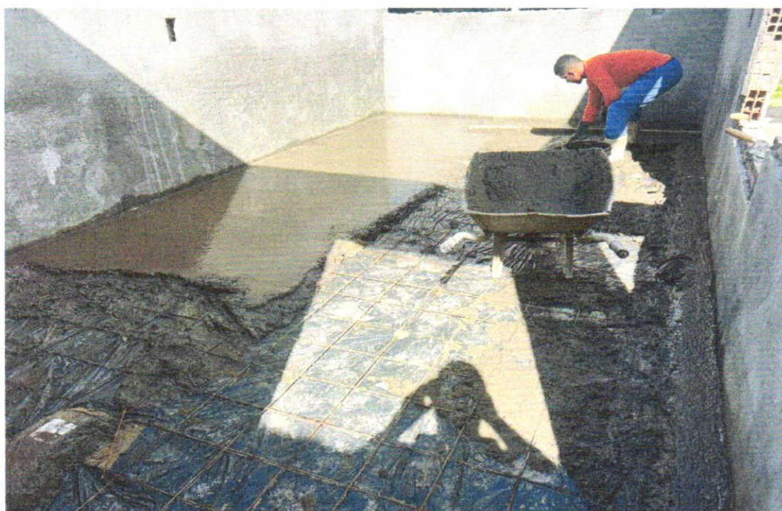
FOTO 40 – Camada regularizadora traço 1:4 (cimento e areia) espessura 2cm
