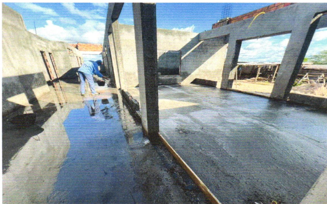
FOTO 42 – Piso cimentado desempenado com acabamento liso espessura 2,0cm com junta plastica acabada 1,2m - solários, varandas e pátio coberto
